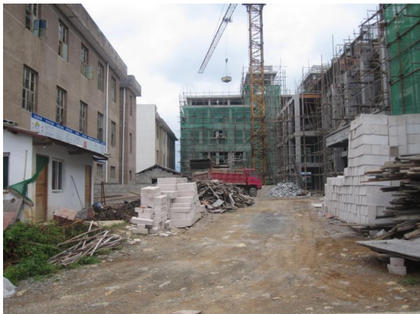
图 16 湖北省恩施市利川县汪营镇苏家桥村苏家桥小学旁边的施工工地
